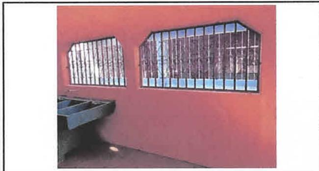
Foto 3: Instalación de balcones de hierro con malla en el área de ventanas.
