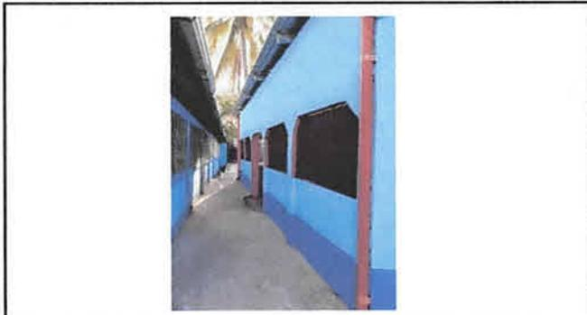
Foto1: Finalización del área exterior de cocina (Cernido, remozamiento y pintado de las paredes y costaneras).
