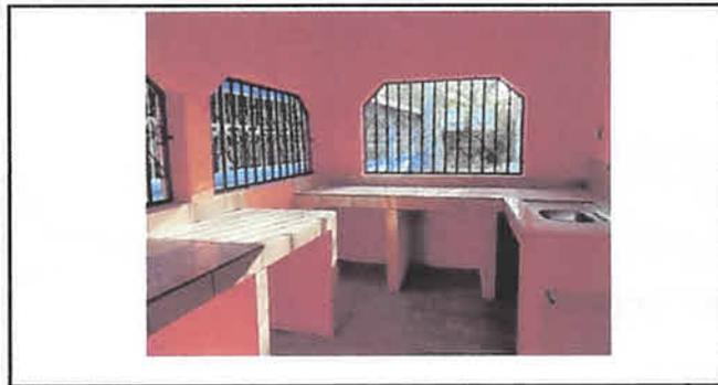
Foto 5: Instalación de azulejos en el area de cocina sobre la pared y plancha donde se prepararan los alimentos.
