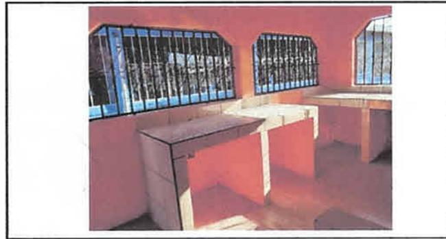
Foto 6: Instalación de azulejos en el area de cocina sobre la pared y plancha donde se prepararan los alimentos.
